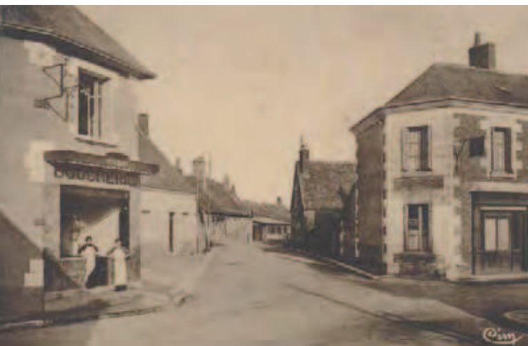
A gauche, le nouvel immeuble et la boucherie après les travaux de 1937
