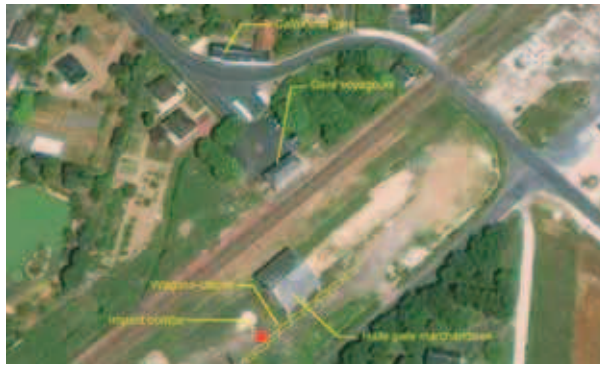
La gare et ses abords vus du ciel en 2010 (avec en rouge l'impact de la bombe) (infographie de l'auteur d'après vue Google-Earth)
